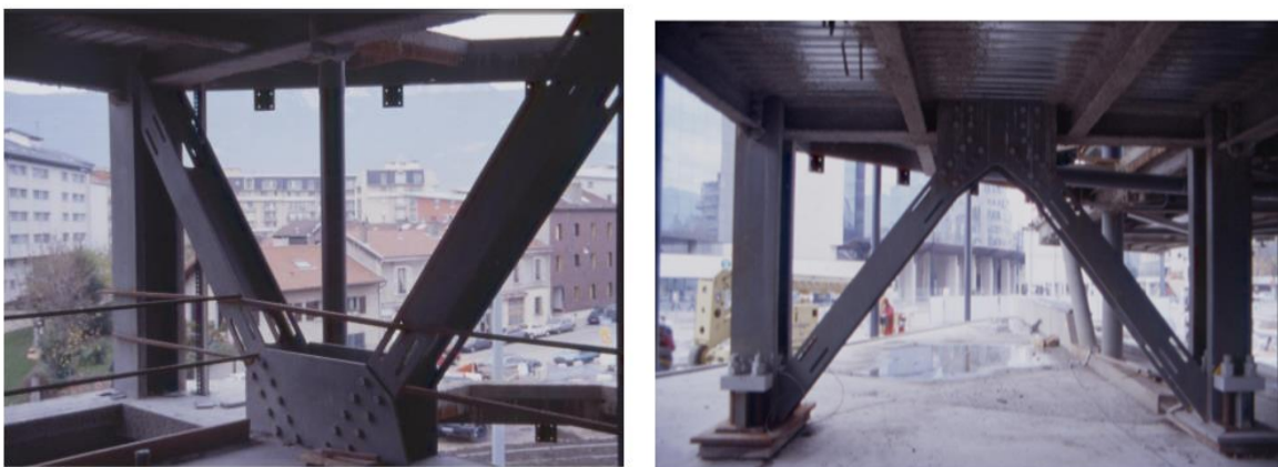
Figure 11 : Contreventement par des barres en V
