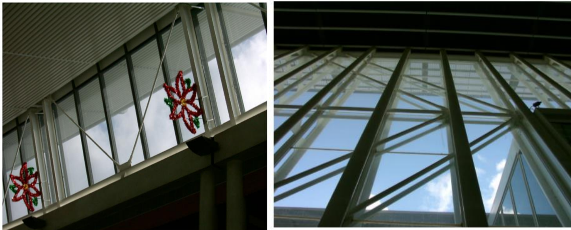
Figure 10 : Contreventement par tirants en triangulation
