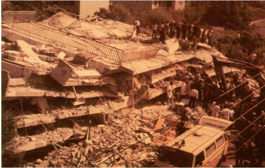
Figure 1: Effondrement total des constructions non ou mal contreventées
