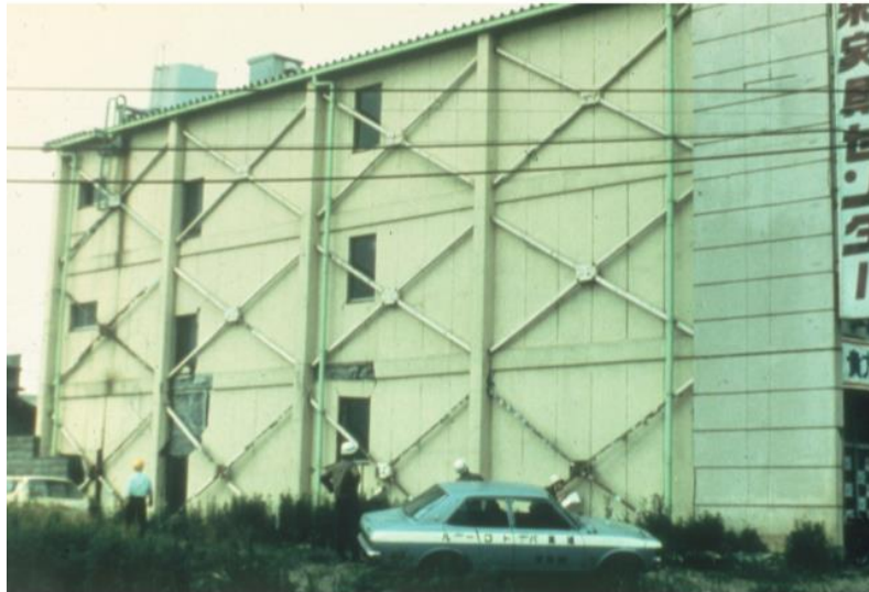
Figure 9 : Contreventement par des barres en X
